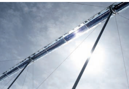
A través de la concentración de la radiación se produce una temperatura de 280° C en los tubos.
